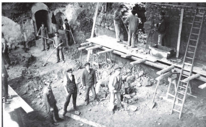
Ausschachten und ausmauern des neuen Kellers
