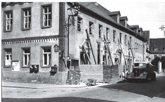
Der historische Teil während der Bauarbeiten
